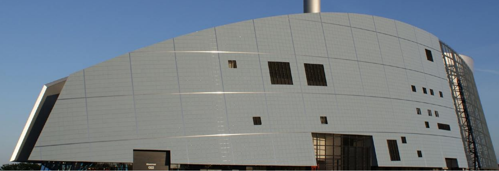
Heizkraftwerke Viborg, Dänemark
